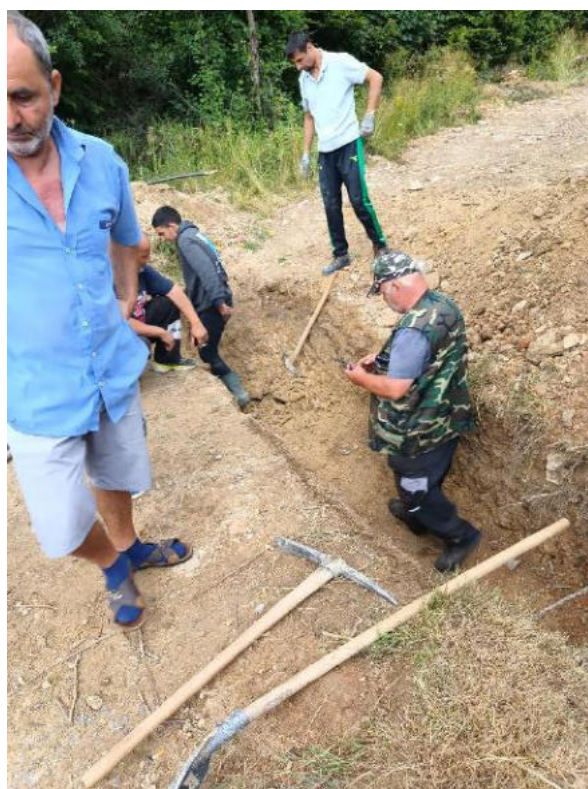
➤ výkopové práce dobrovolníků
